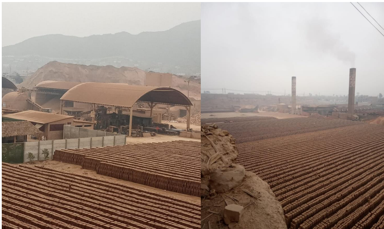
Figura 10: Testimonio fotográfico de la producción de ladrillos Anexo 8 Jicamarca Huarochiri Lima
